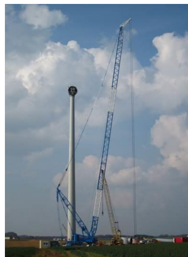
Photo 9 : Montage d'une éolienne
