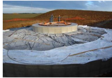
Photo 7 : Mise en œuvre du revêtement d'étanchéité
