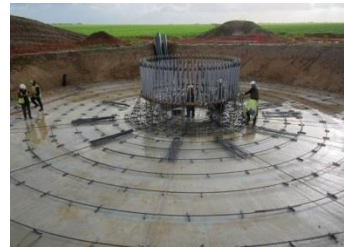
Photo 4 : Béton de propreté coulé et mise en œuvre de l'anchor cage (Source : WKN France)
