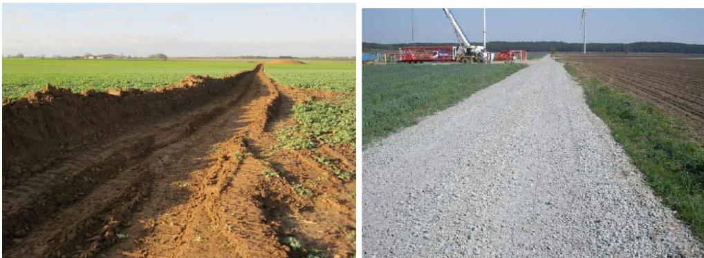
Photo 2 : Exemple de réalisation d'accès
