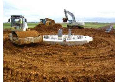
Photo 8 : Remblaiement de la fondation
