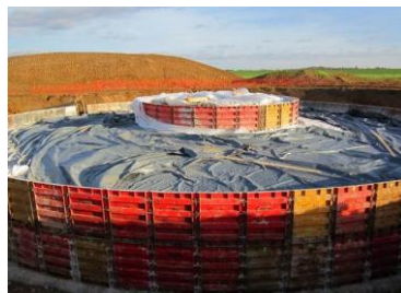
Photo 6 : Coffrage de la fondation (Source : WKN France)
