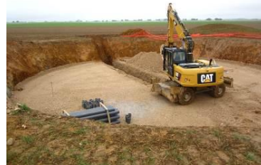
Photo 3 : Excavation pour la fondation (Source : WKN France)
