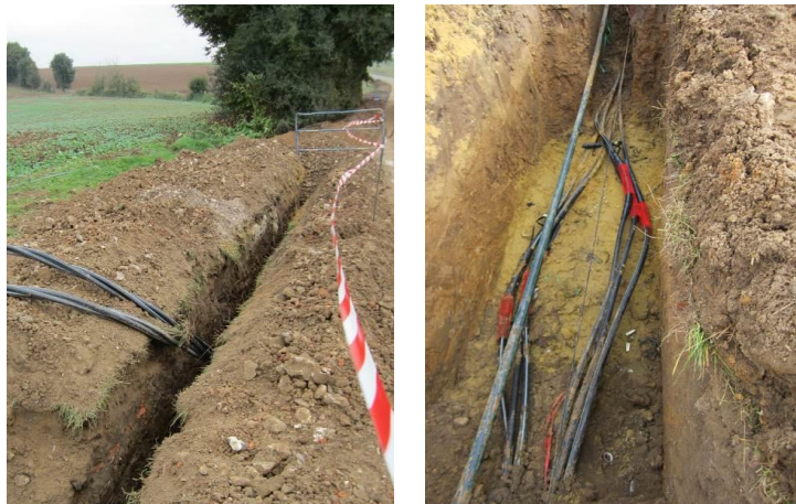
Photo 10 : Exemple de tranchées de raccordement
