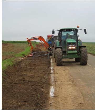
Photo 11 : Exemple de tranchées de raccordement en bord de route (Source : WKN France)
