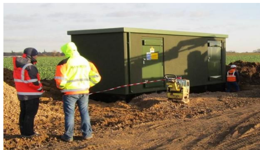
Photo 1 : Exemple de poste de livraison en cours d'installation
