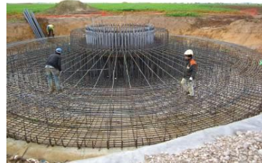
Photo 5 : Ferrailage de la fondation (Source : WKN France)
